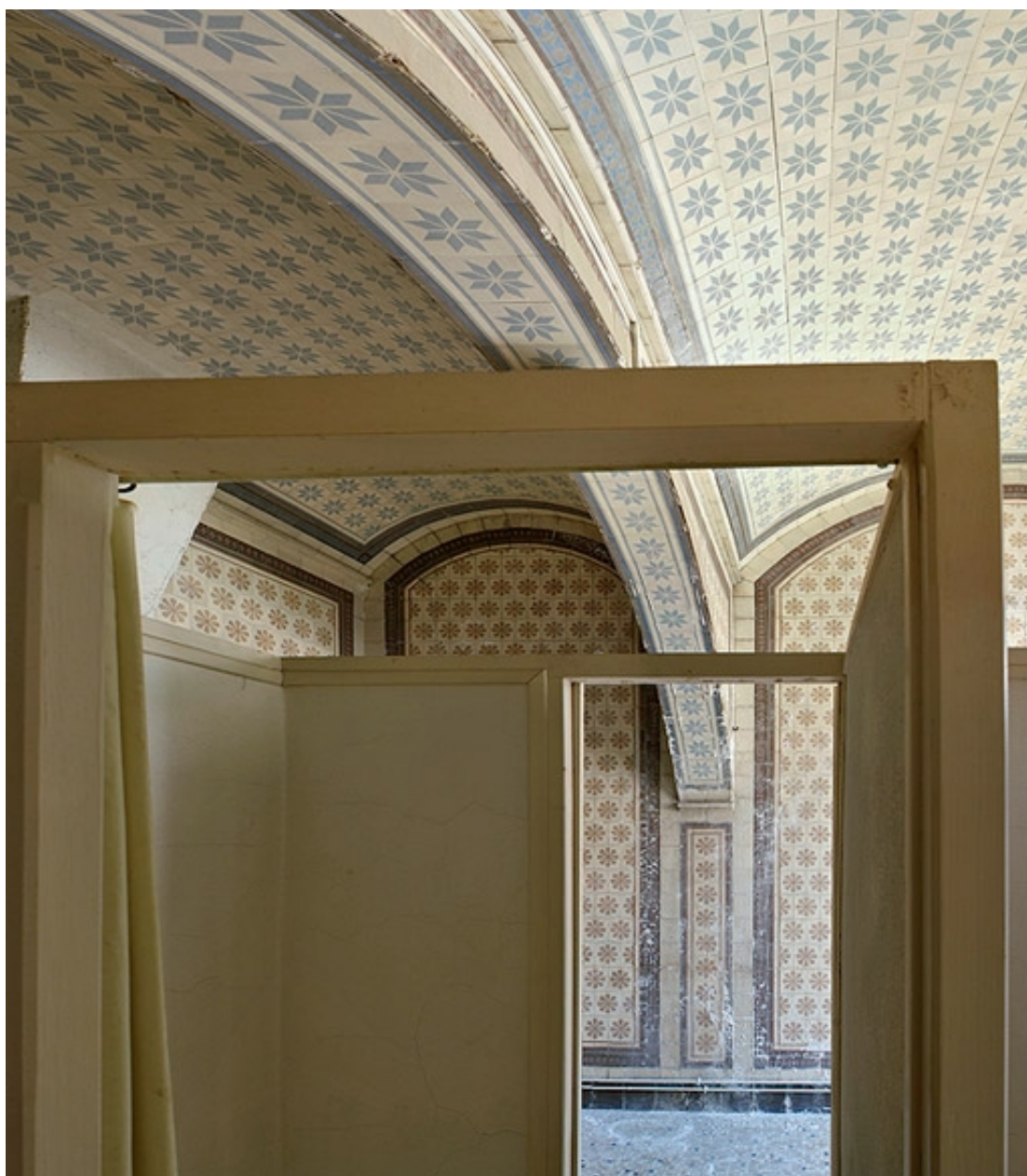
Corps central, cabinet du médecin, voûtes.
