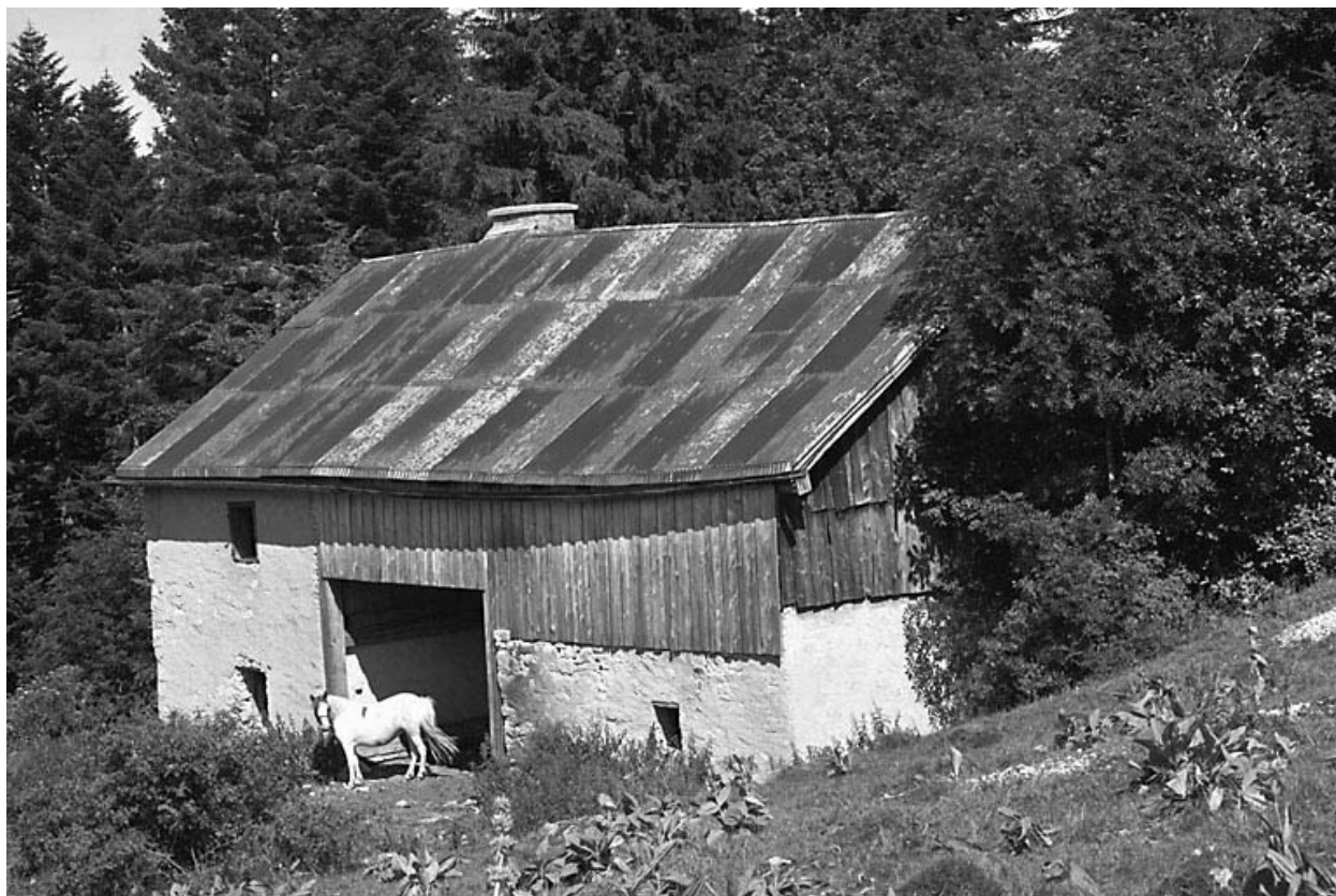
Les Hôpitaux-Vieux, lieudit La Côte : chalet d'estive.
