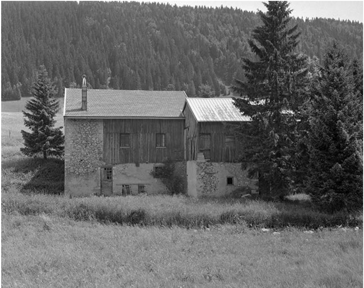
Façade le long de l'Orbe.
