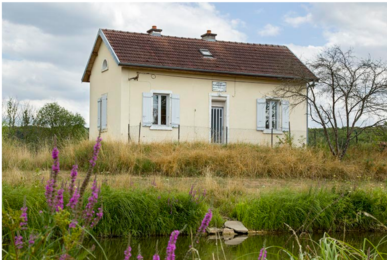
La maison d'éclusier.
