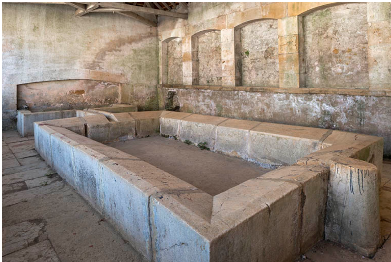
Le bassin du lavoir.
