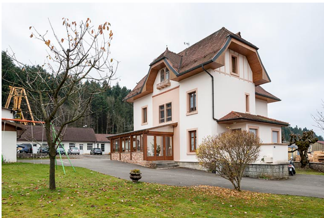
Logement patronal : façades nord et est.
