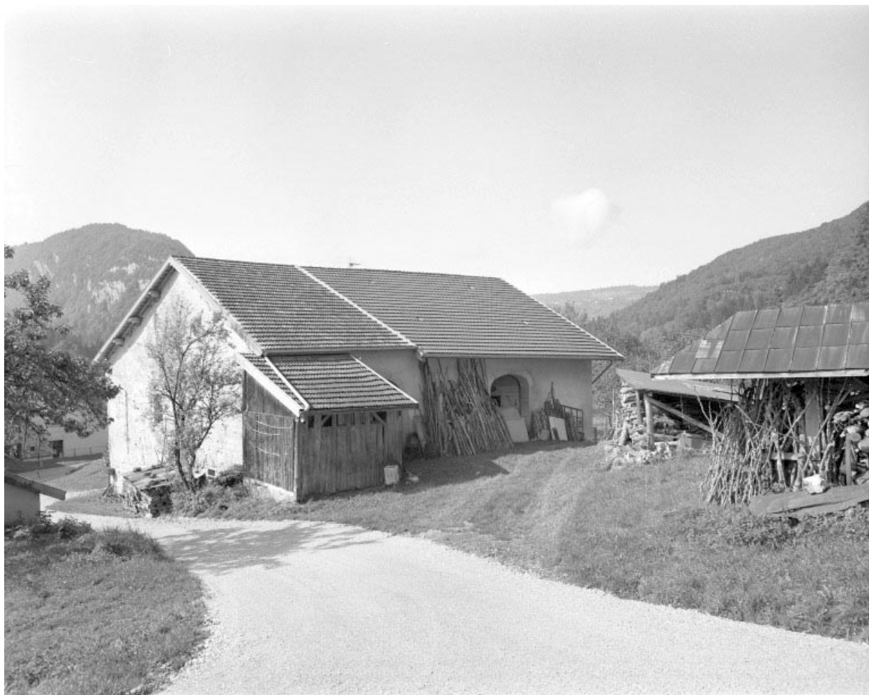
Vue générale de la façade postérieure.
