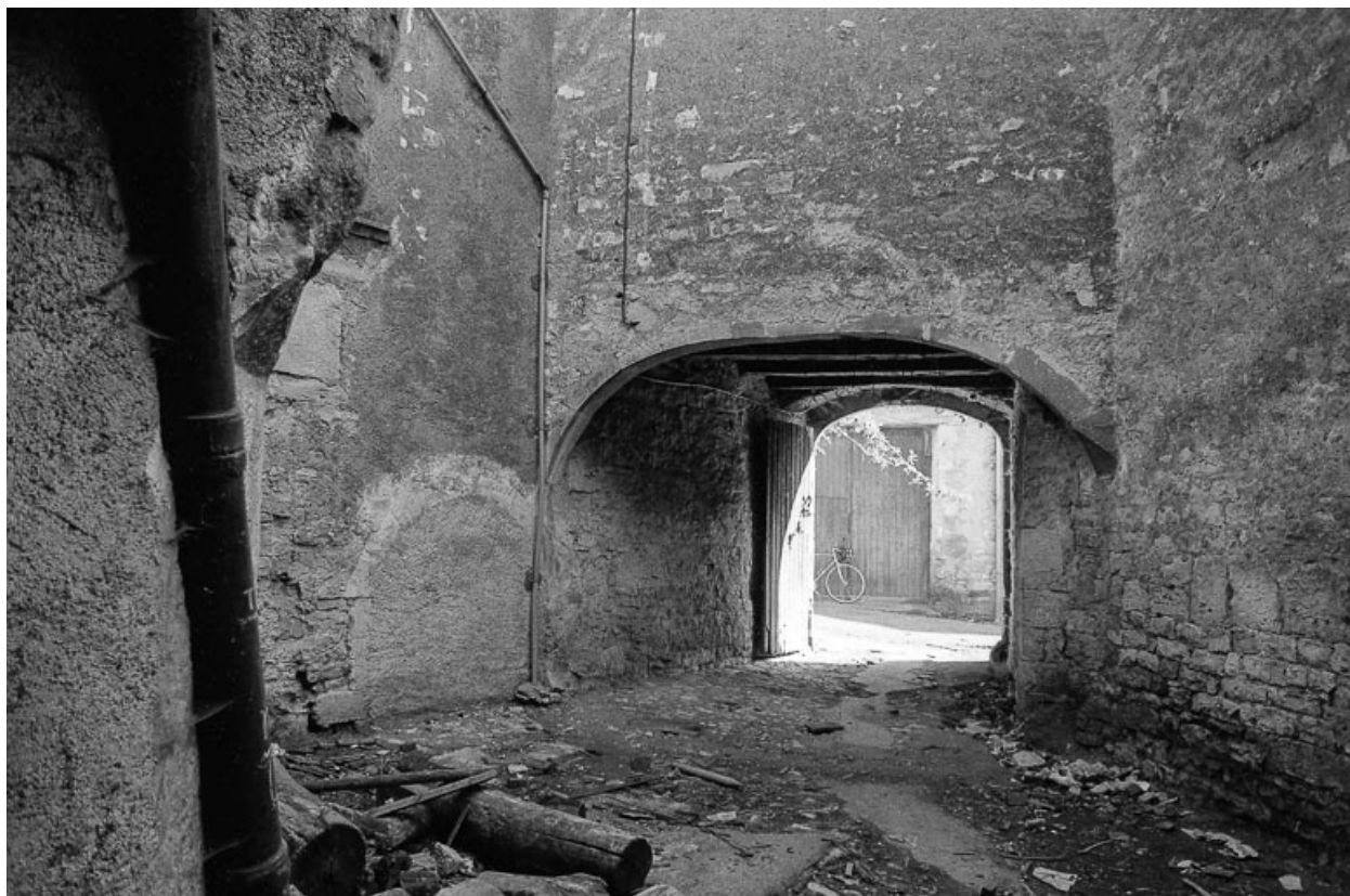
Vue du porche depuis la cour.
