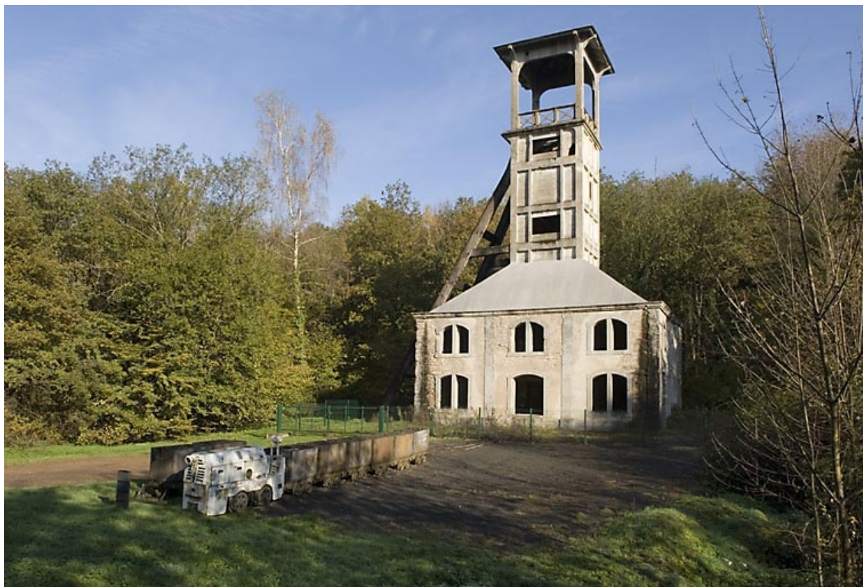
Le chevalement. Vue d'ensemble depuis le sud-ouest.
