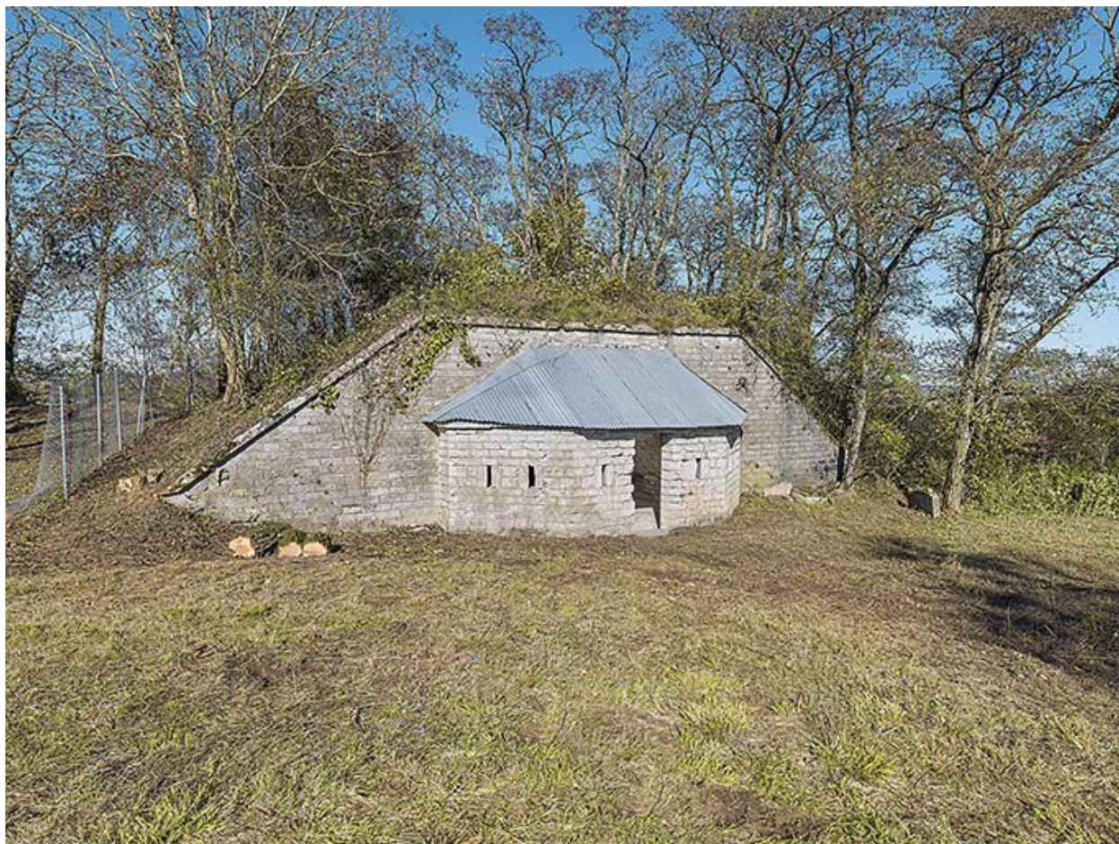
Traverse-abri de la batterie à gorge retranchée.
