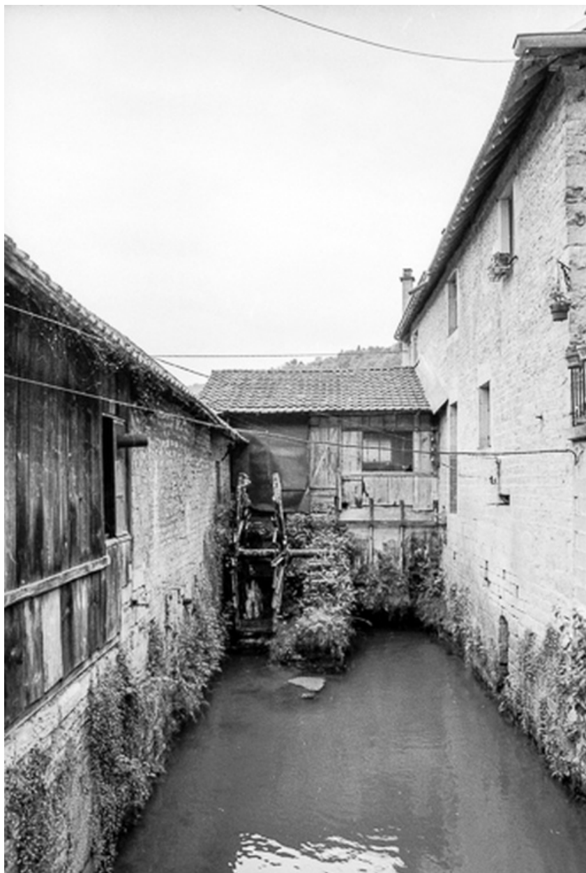
L'atelier et sa roue hydraulique depuis l'aval en 1980.
