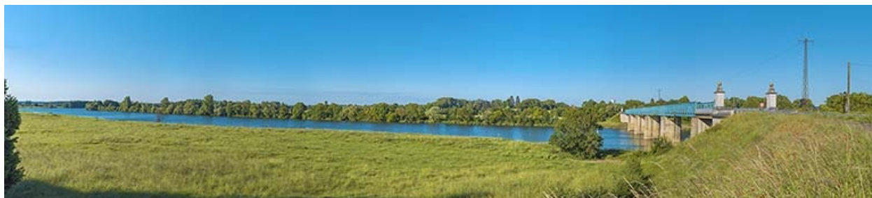
Le pont, vu d'aval.
