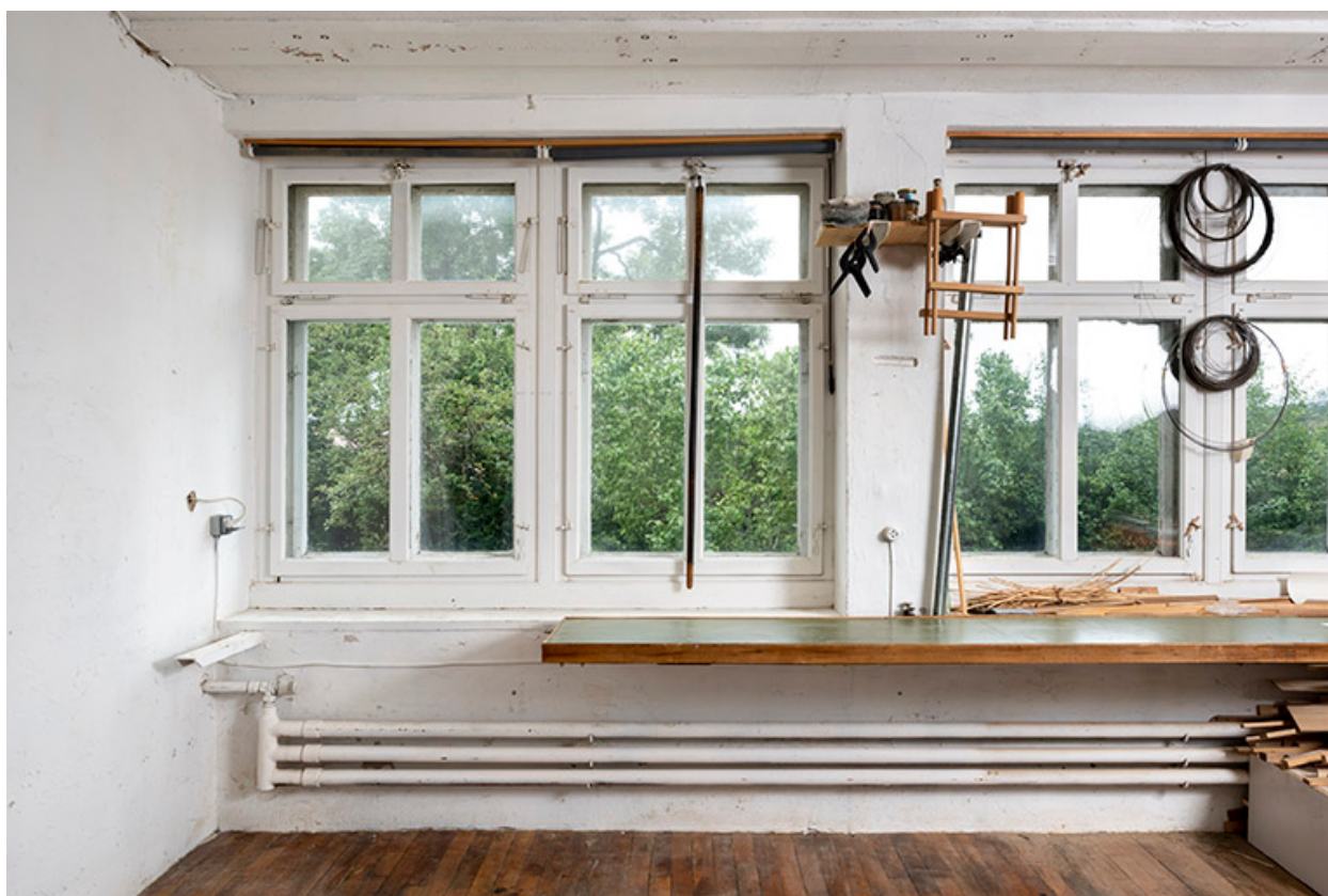
Usine, atelier : fenêtres horlogères, établi et chauffage.
