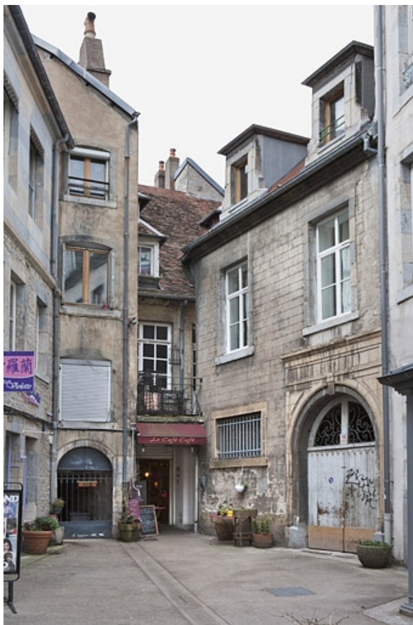
Façade postérieure des communs donnant sur l'impasse.
