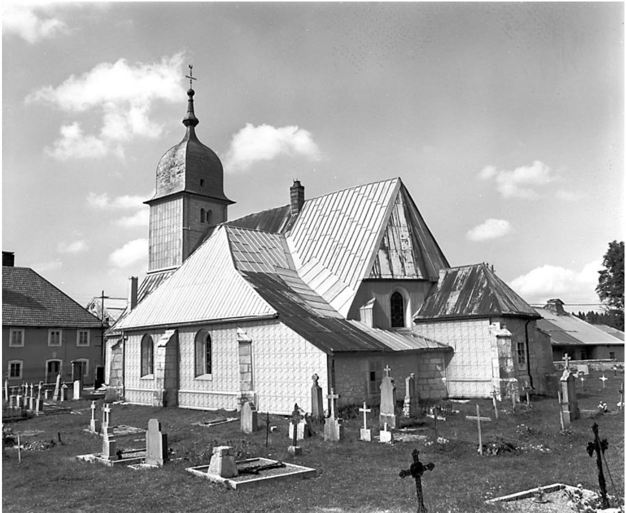
Façades postérieure et latérale droite.
