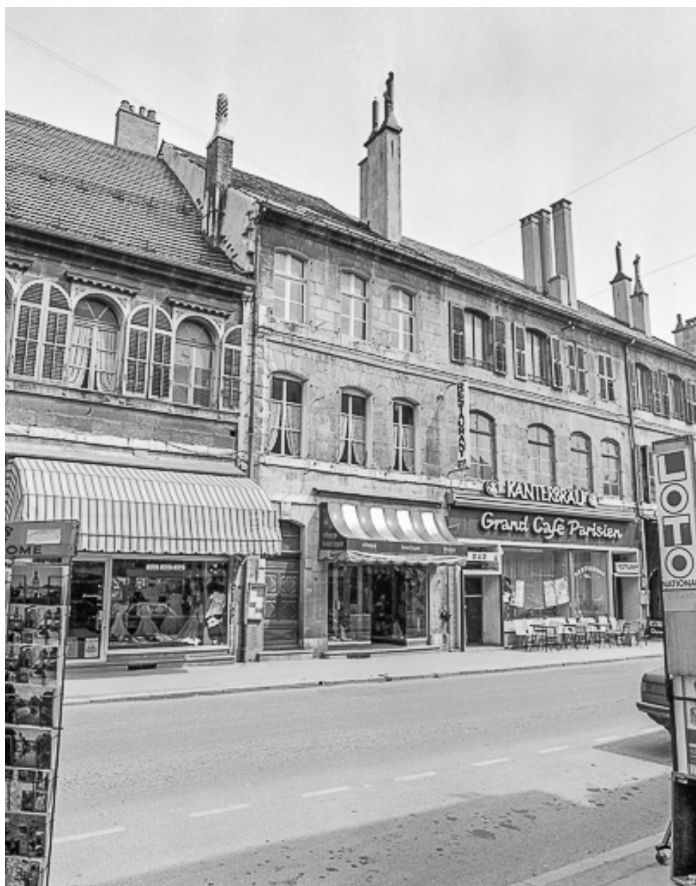
Façades sur rue.
