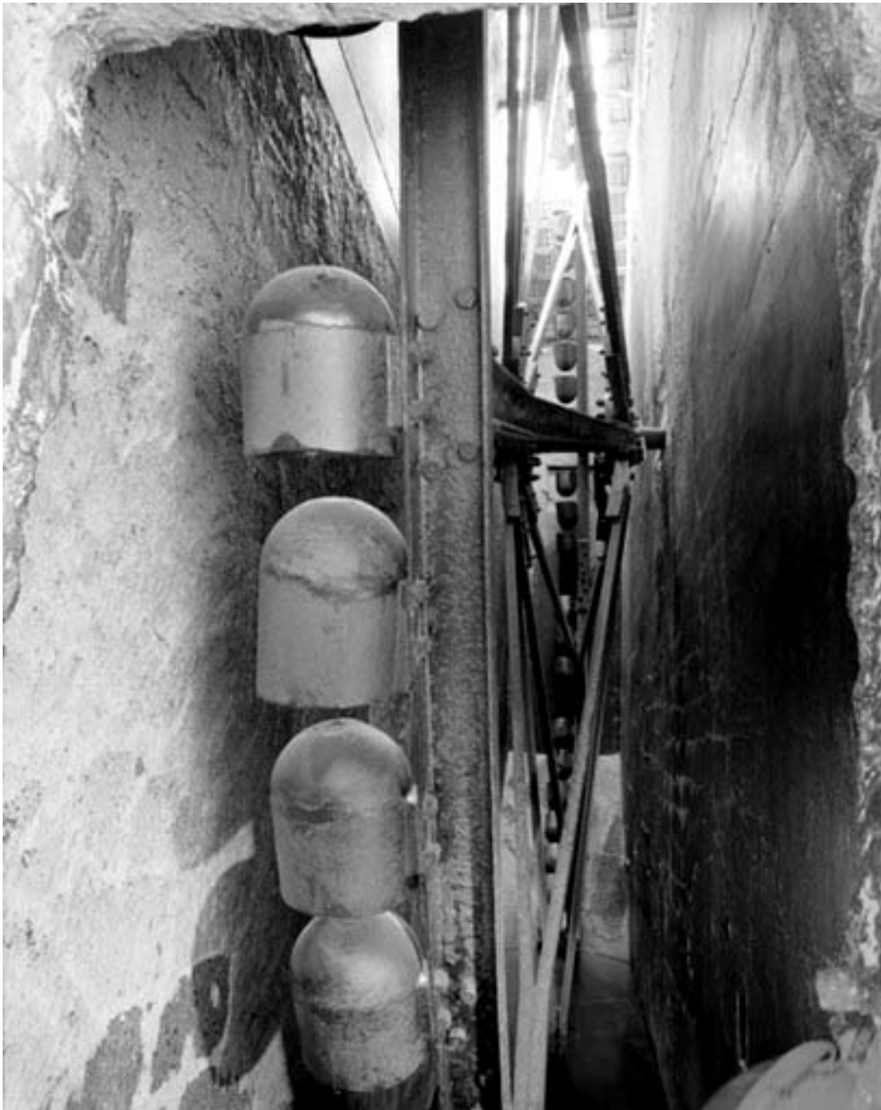
Système de distribution du mélange eau-sable : distributeur et tamis.
