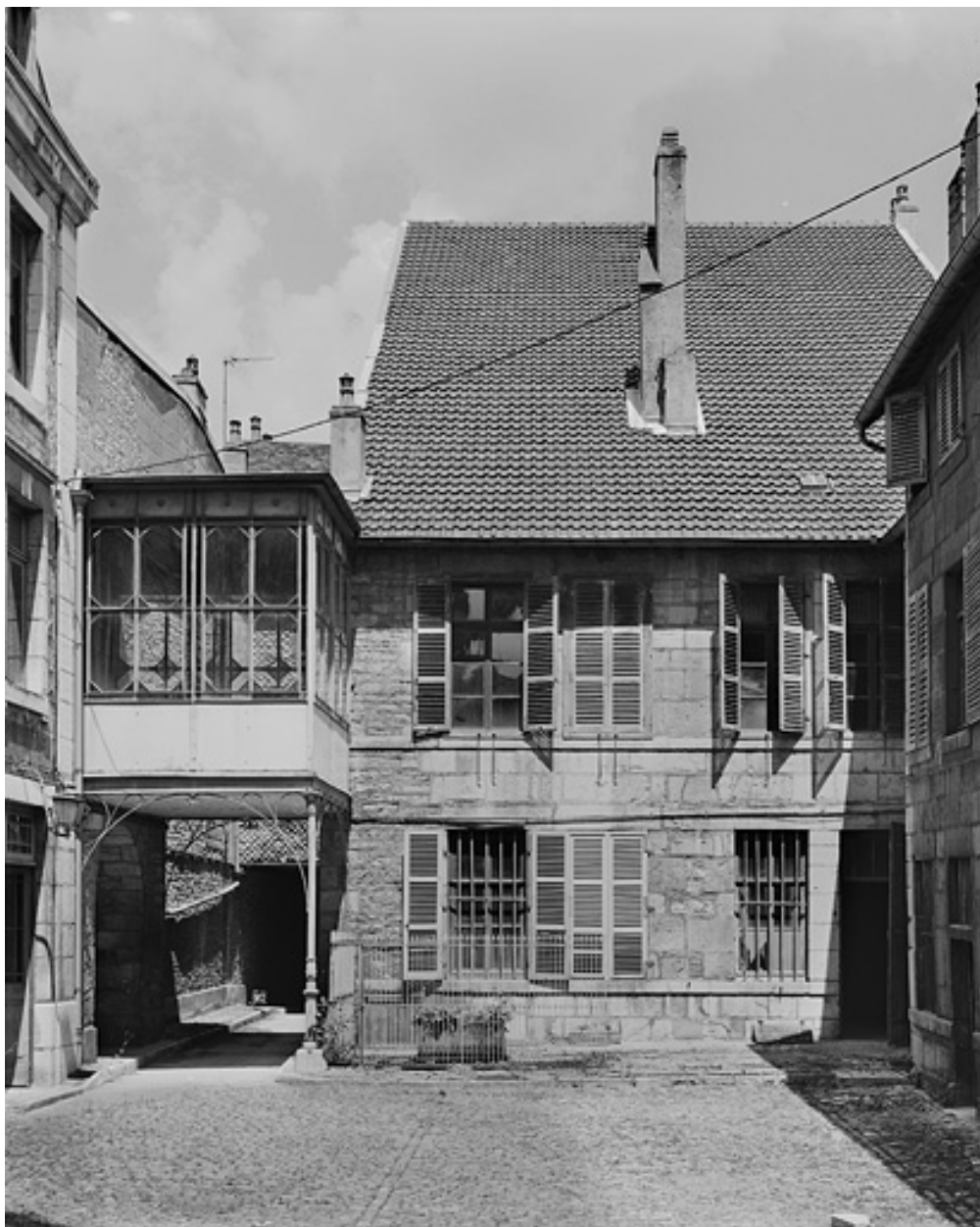
Logis sur rue : façade postérieure.
