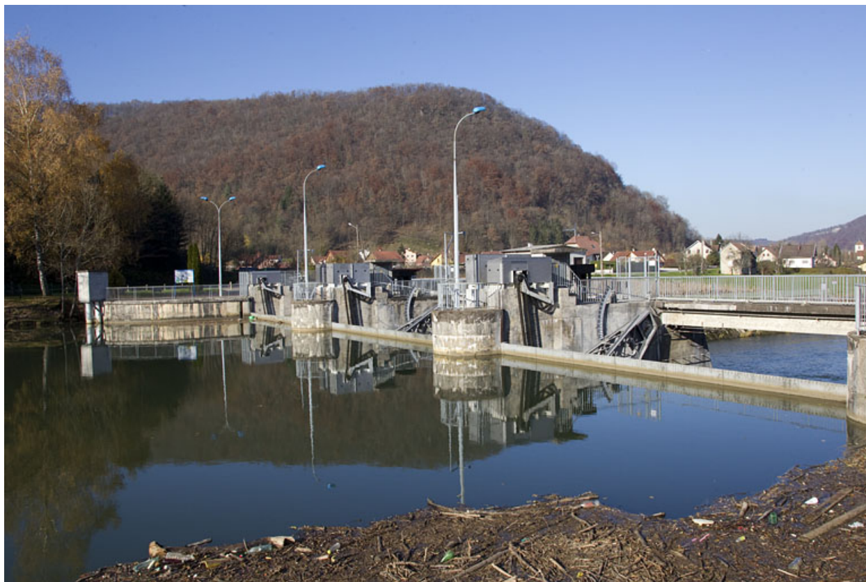
Le vannage en amont du barrage.
