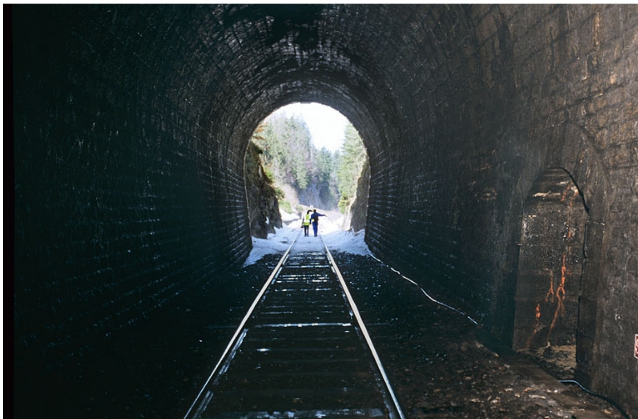
Intérieur (côté Andelot-en-Montagne) : tête et refuge.
