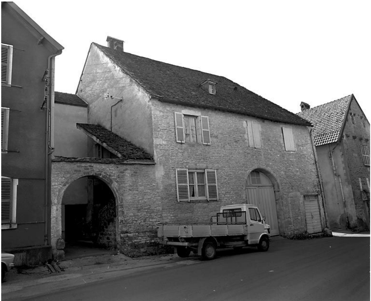
Maison située 8 rue Edouard Bastide.
