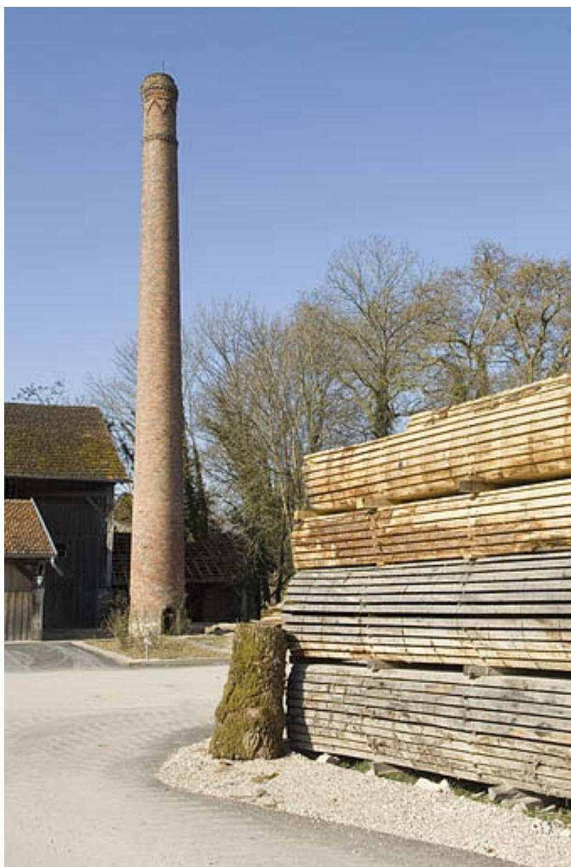
Cheminée depuis le nord-est.
