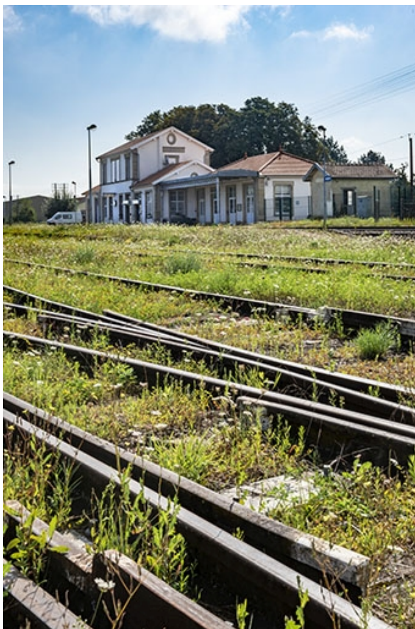
La gare, vue éloignée depuis les voies.
