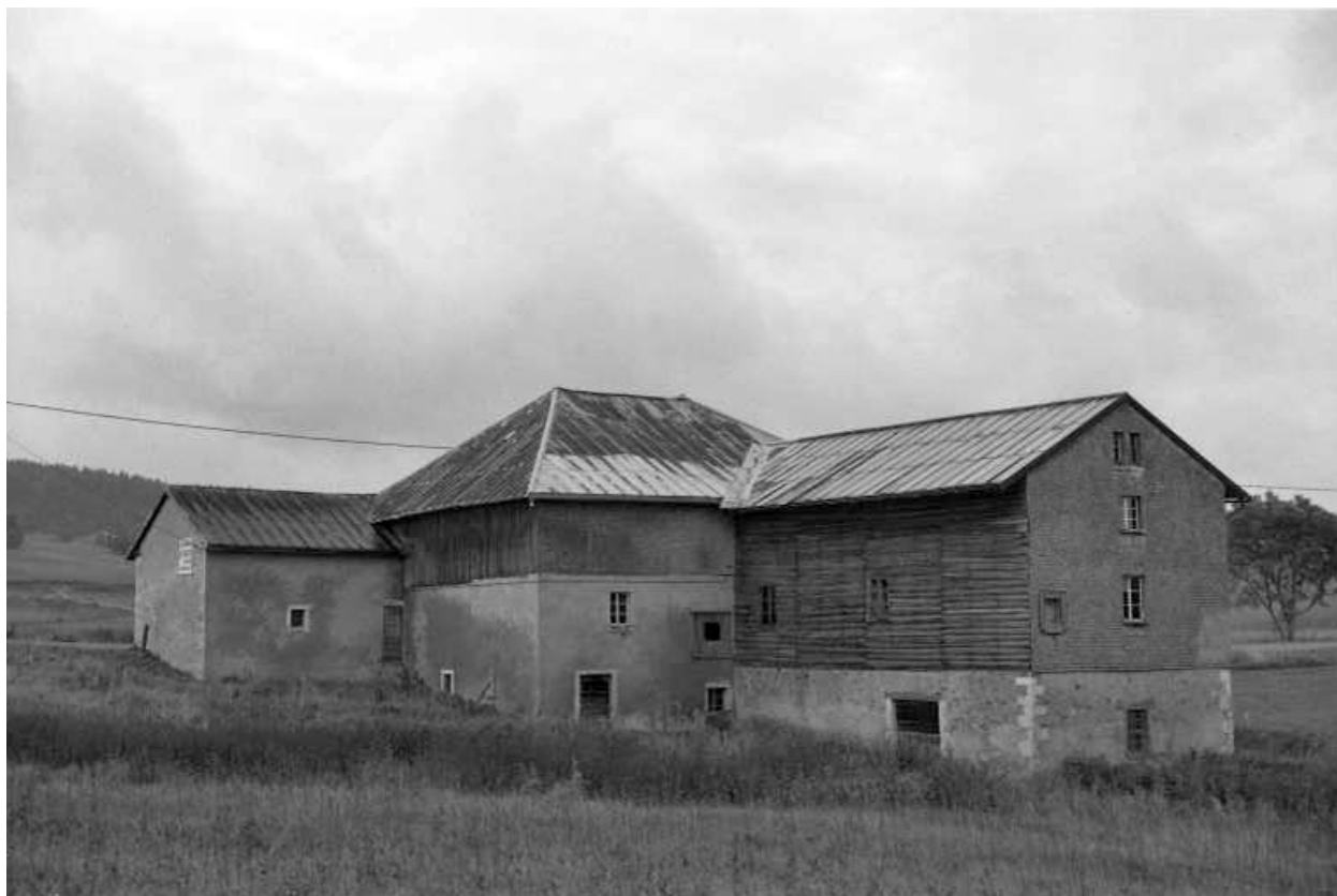
Vue d'ensemble depuis le nord (façades postérieures).
