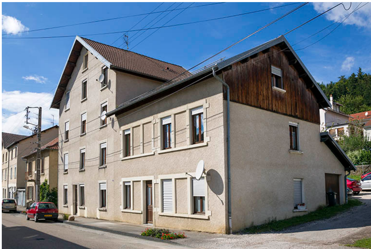
Façades antérieure et latérale droite.
