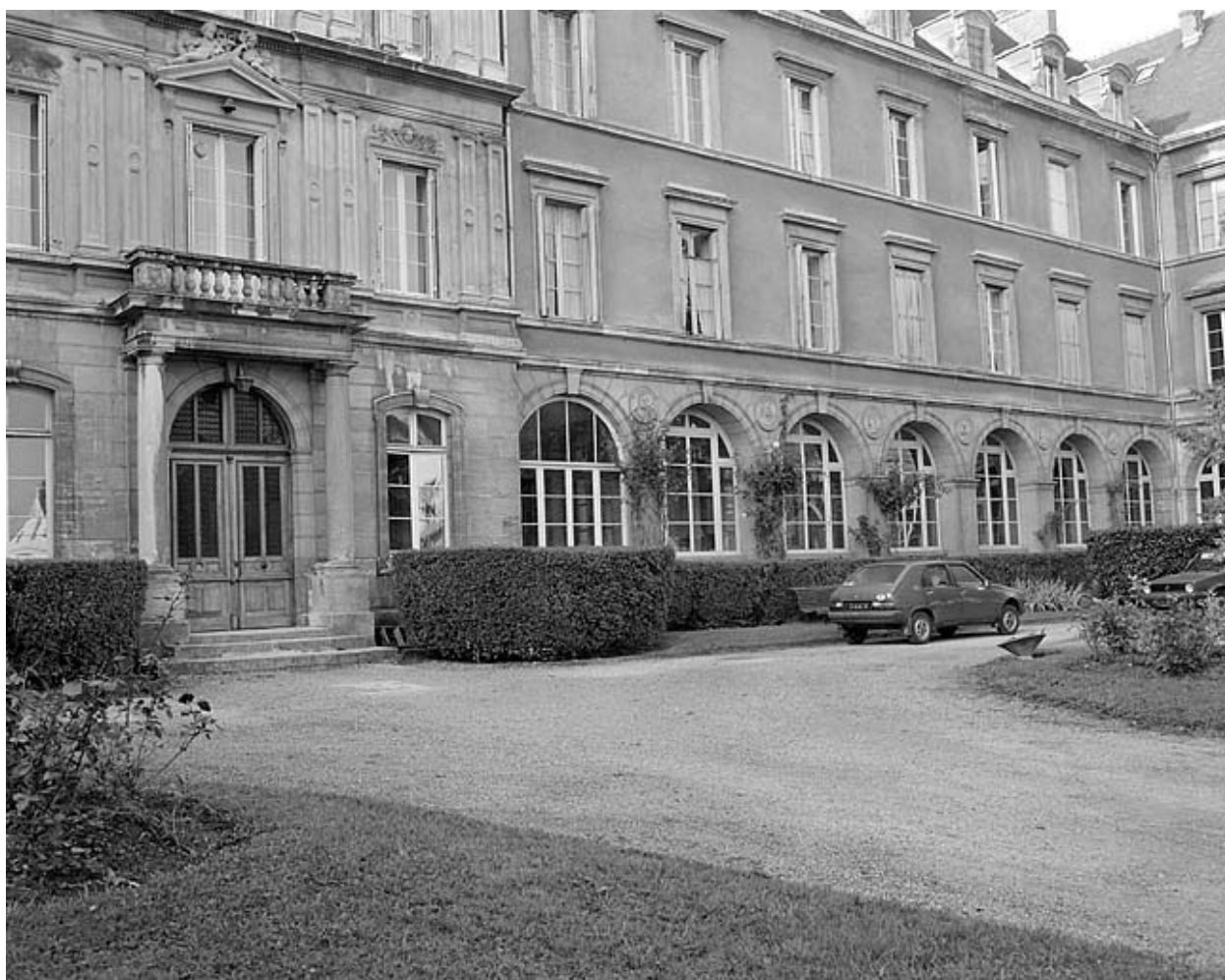
Façade antérieure, partie droite.
