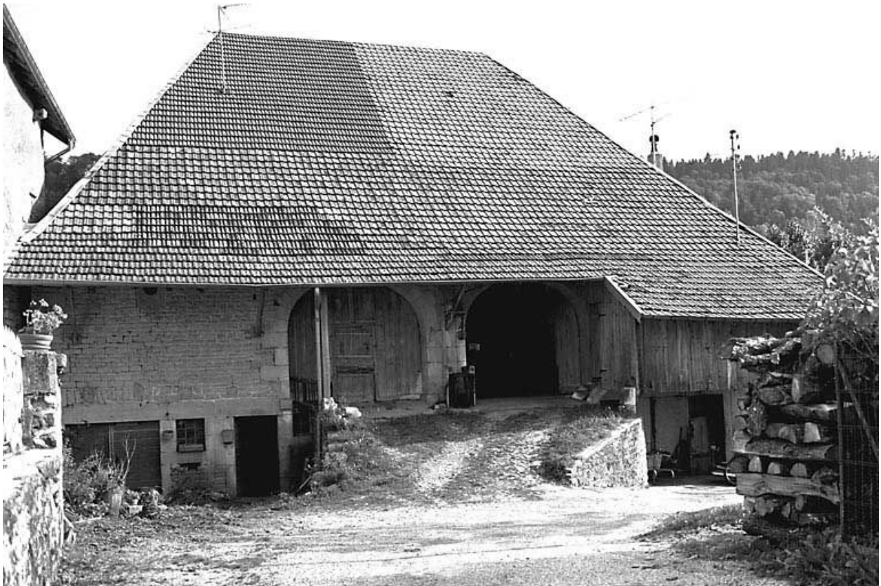
Ferme située rue de l'Ecole.
