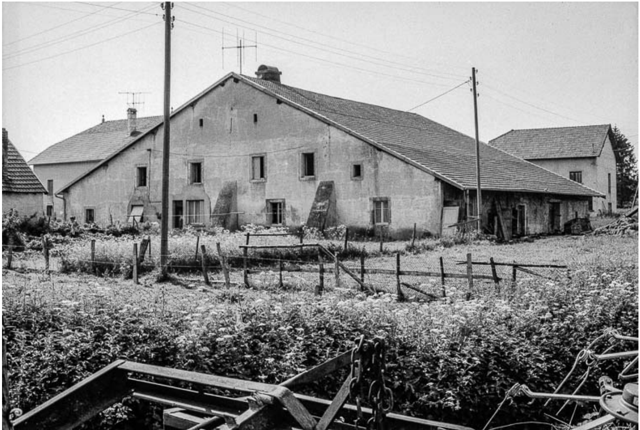
Ferme datée de 1750, cadastrée 1938 F 56 : façade antérieure.
