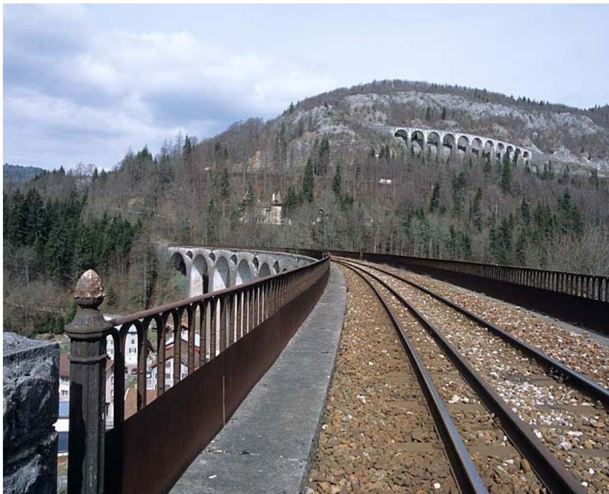
Tablier et garde-corps métallique côté Andelot-en-Montagne.
