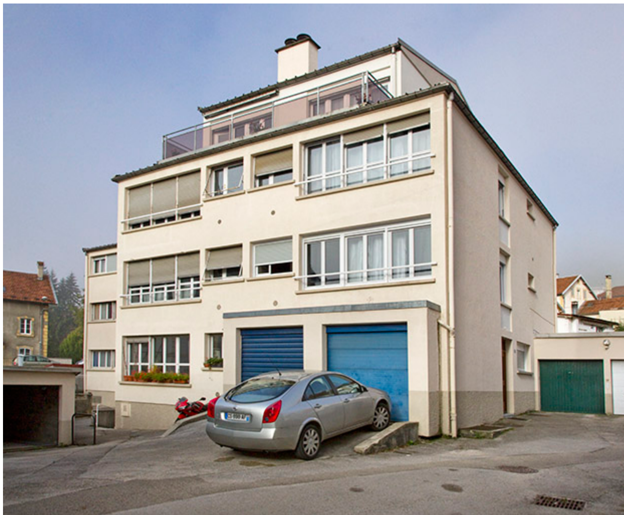
Bâtiment sud : façades antérieure et latérale droite.
