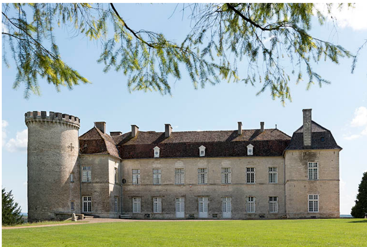
Vue générale de la façade nord.
