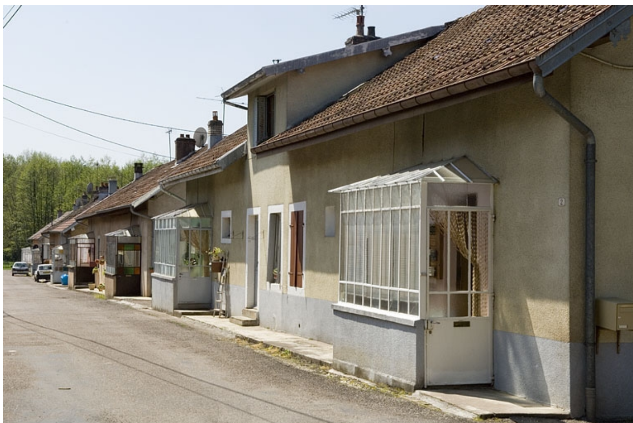
Alignement de façades de la cité ouvrière.
