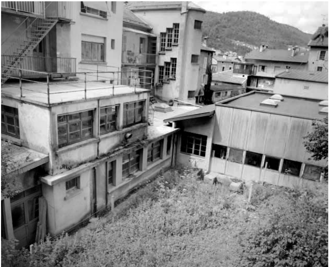
Ateliers de fabrication. Atelier de 1967 à droite.
