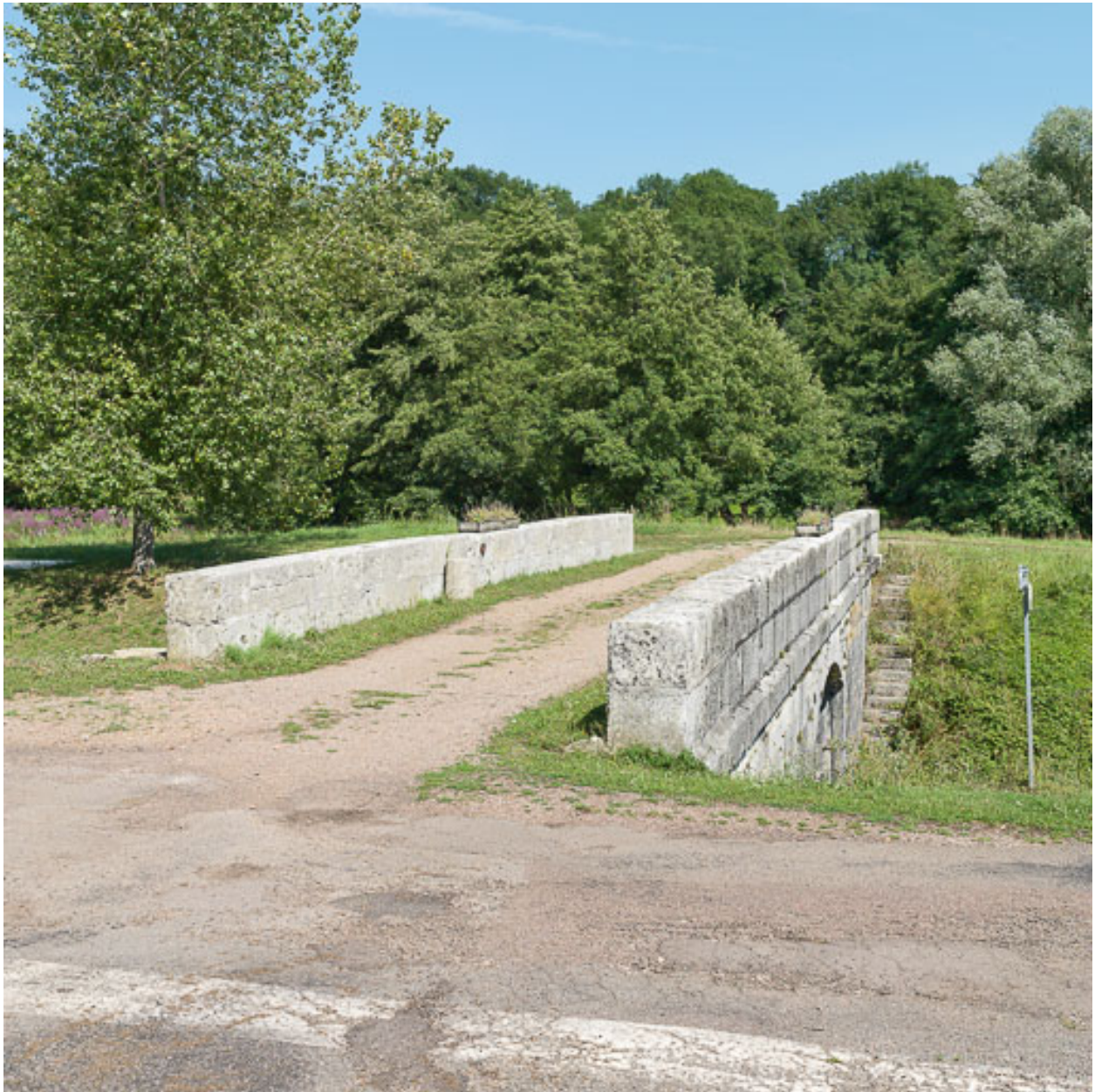
Vue du pont.
