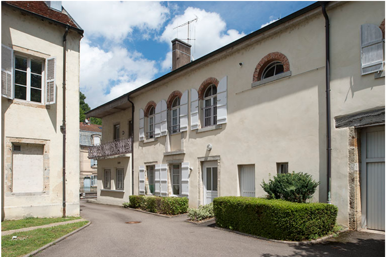
Les communs, vue depuis la cour.
