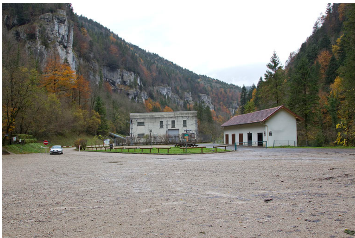
Vue d'ensemble, depuis le sud (amont).
