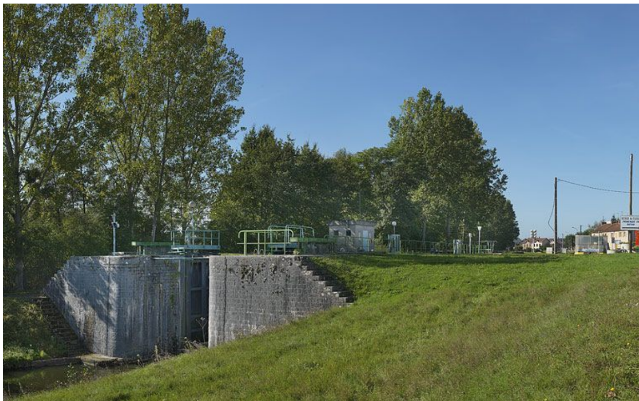
Le site d'écluse 06 vu d'aval.
