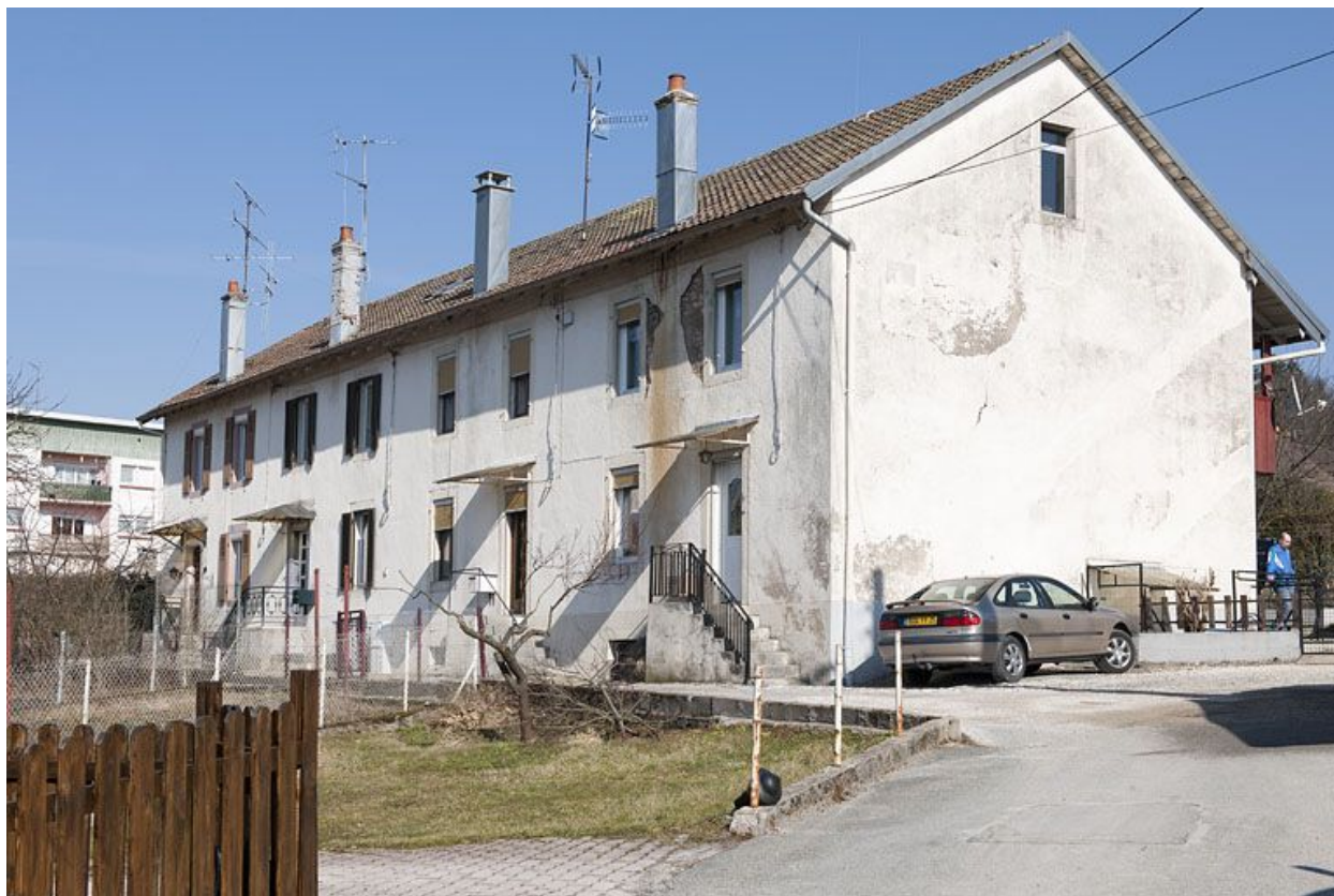
Habitation à 8 logements (?) rue du Nègre.
