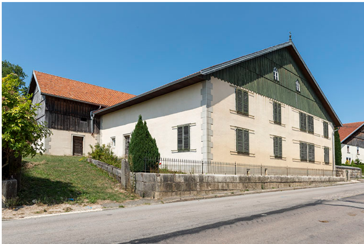
Façades postérieure et latérale gauche.
