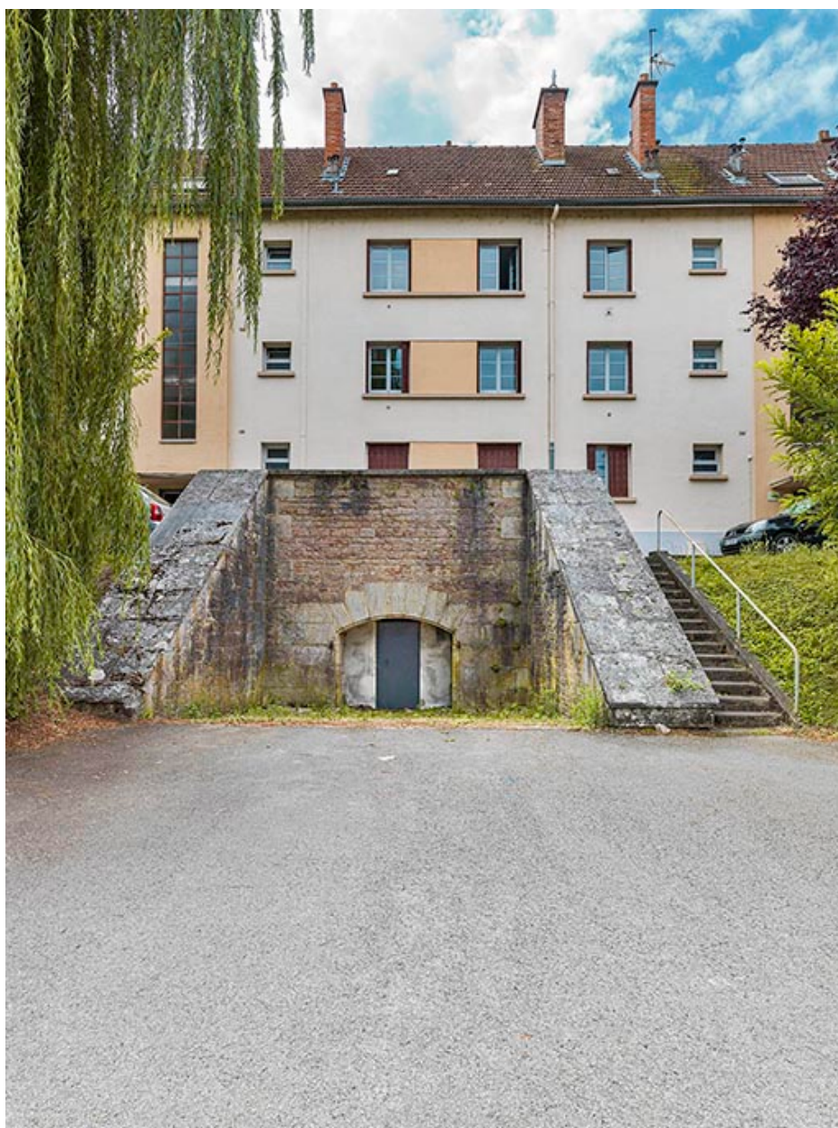
La poterne, vue générale.
