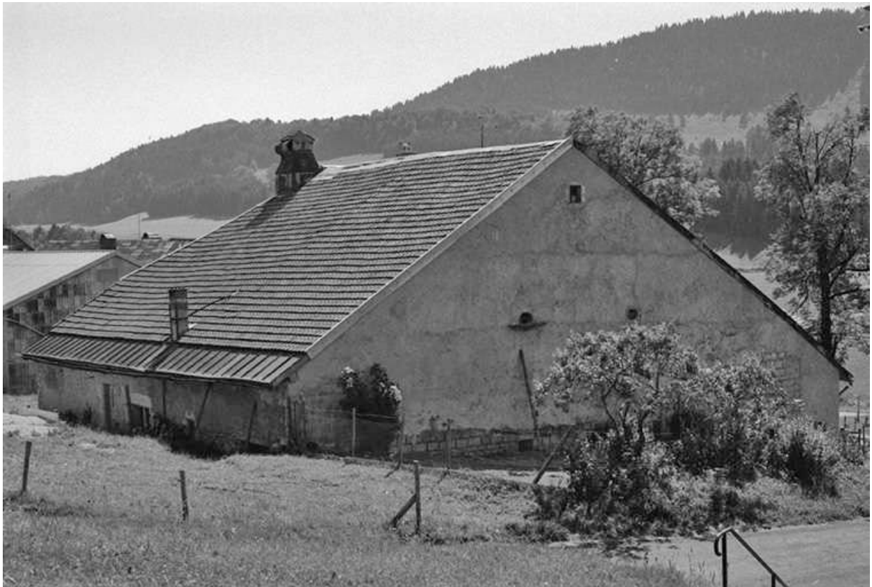
Façades postérieure et latérale gauche.
