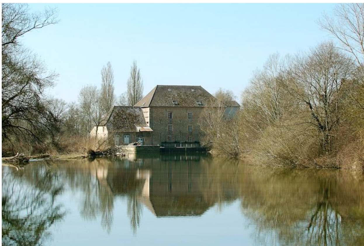
Moulin de Loisy, vu d'amont.
