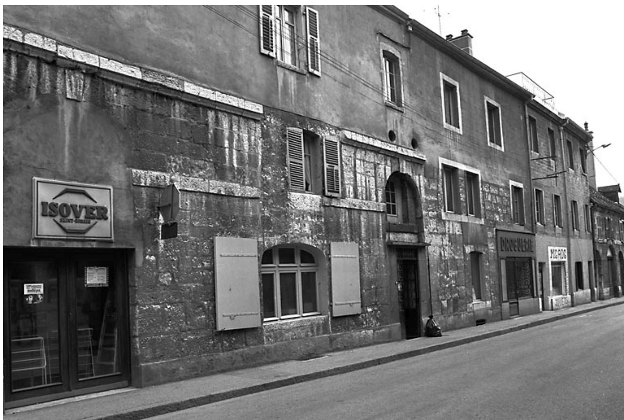
Façade sur la rue Montrieux.
