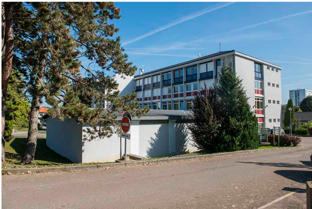
Façade sud de l'amphithéâtre.
