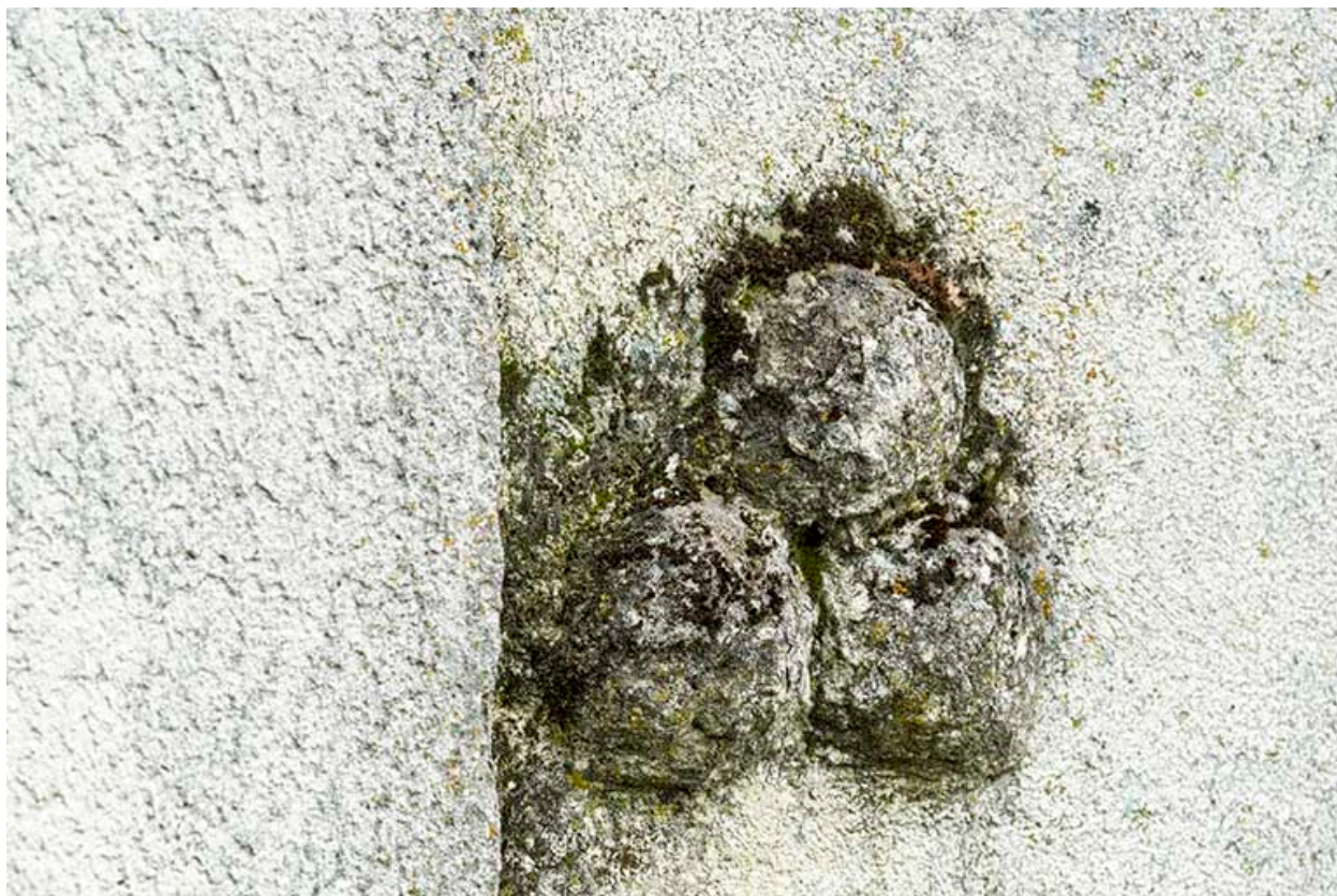
Bâtiment de 1723, façade latérale gauche : boules apotropaïques.
