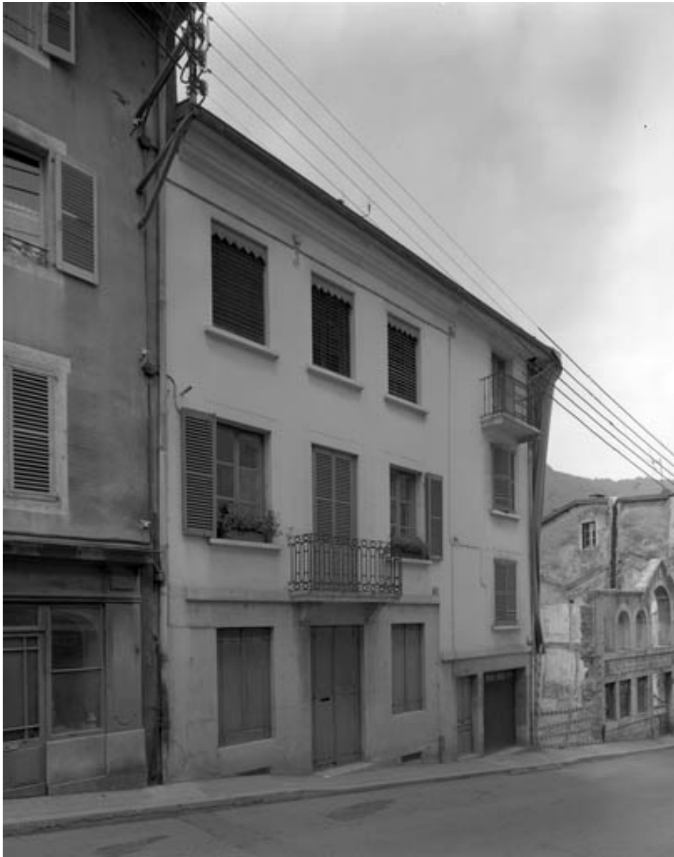
Façade antérieure du logement patronal.
