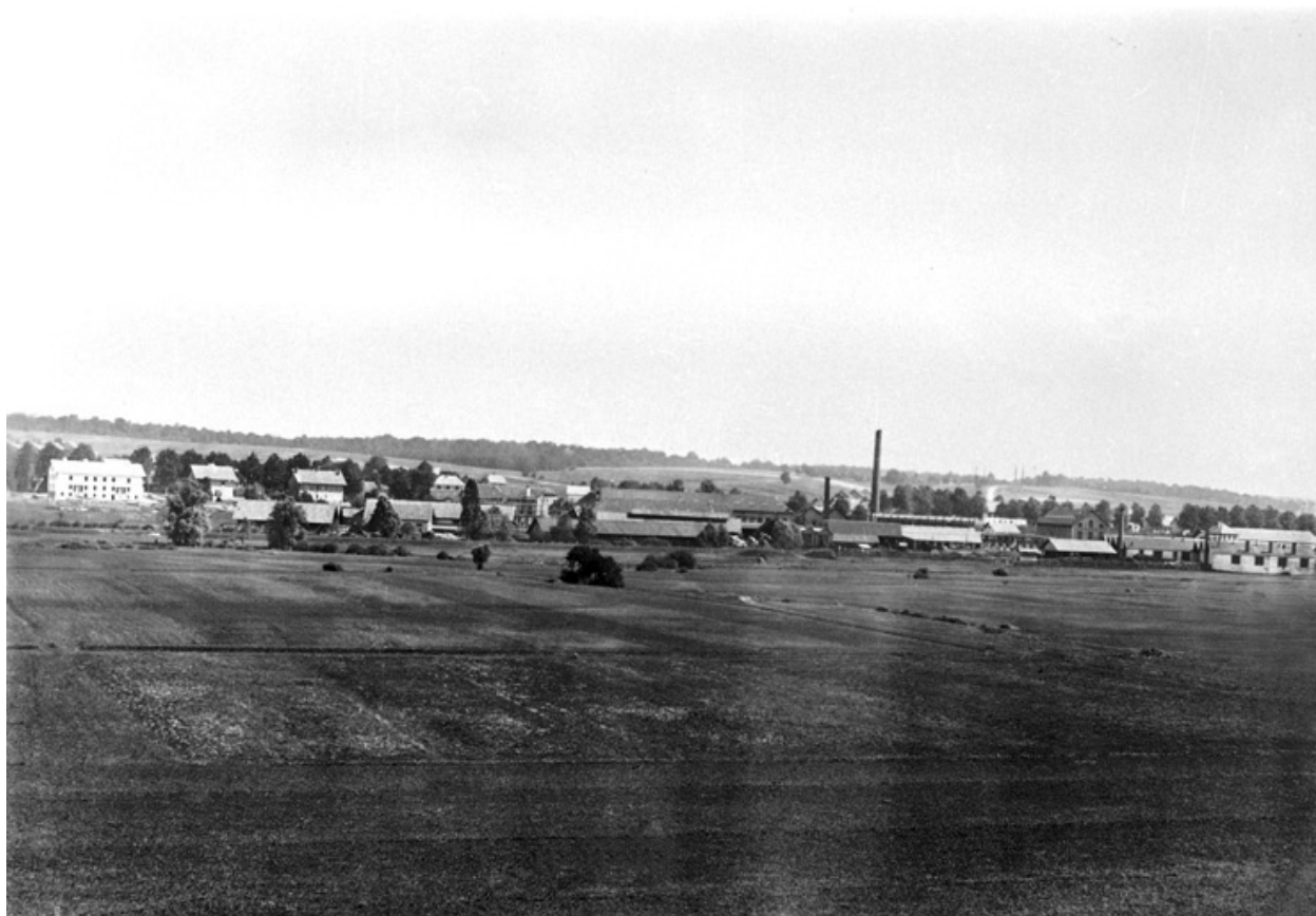
Les Forges de Grandvillars depuis l'ouest.
