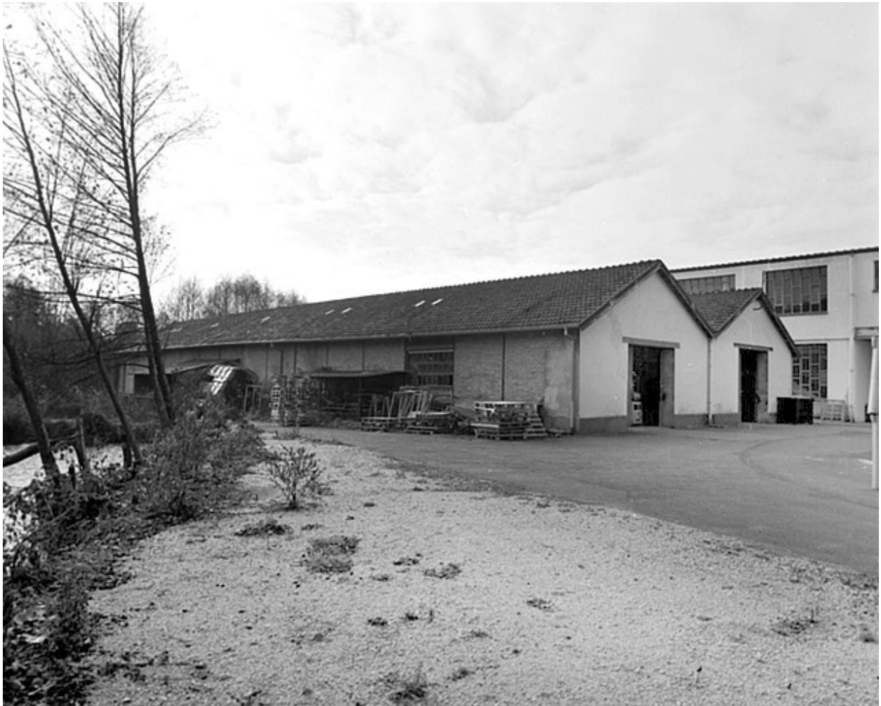
Magasin ou entrepôt industriel (?).
