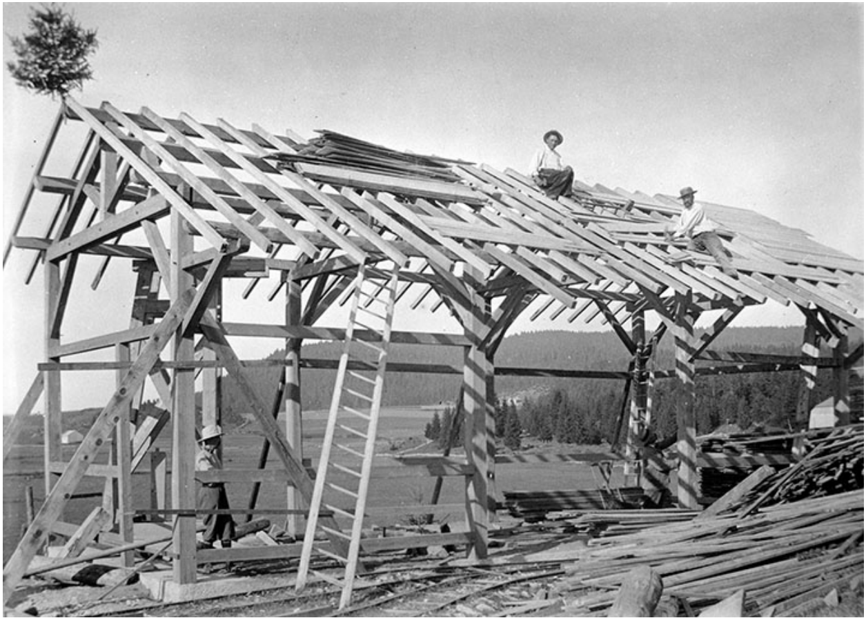
Scierie Paget puis Girardet, Saint-Laurent-en-Grandvaux (la Savine) : construction du bâtiment de la parqueteuse, 1904.
