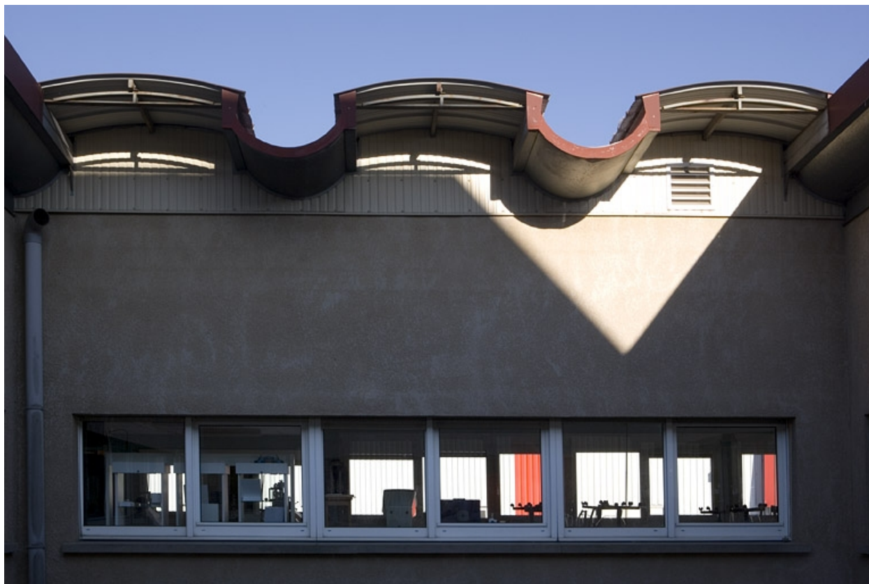
Site récent, atelier d'horlogerie : toiture.
